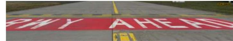
Rollhaltmarkierung mit zusätzlicher Hotspot-Kennzeichnung auf den Rollwegen.
